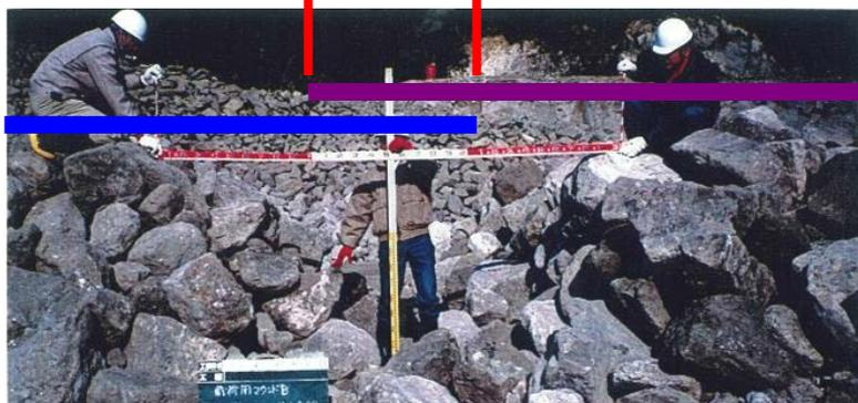
シートが落ち込みむと重ね幅が不足する。
