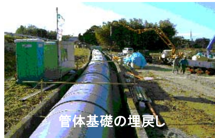
配管部の埋戻し
