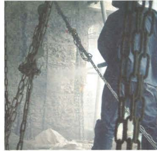
断面修復作業(吹き付け中)
