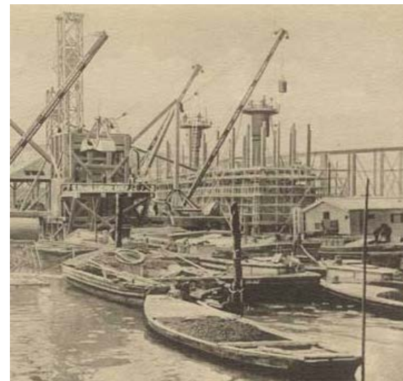
永代橋の施工状況
