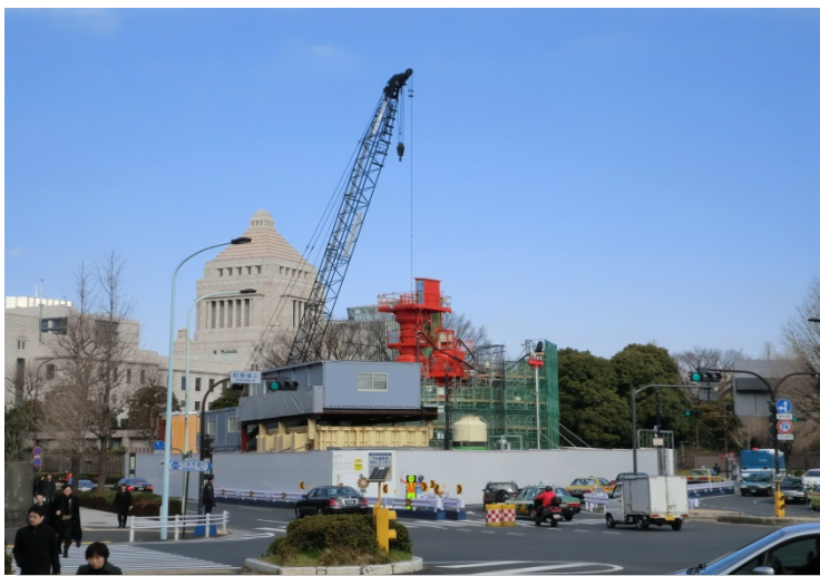
東京都永田町付近再構築立坑
