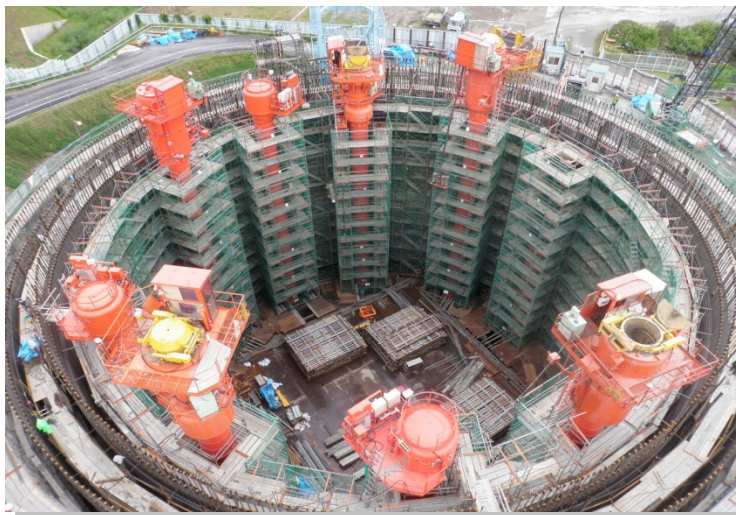
大阪府寝屋川北部地下河川讚良立坑
